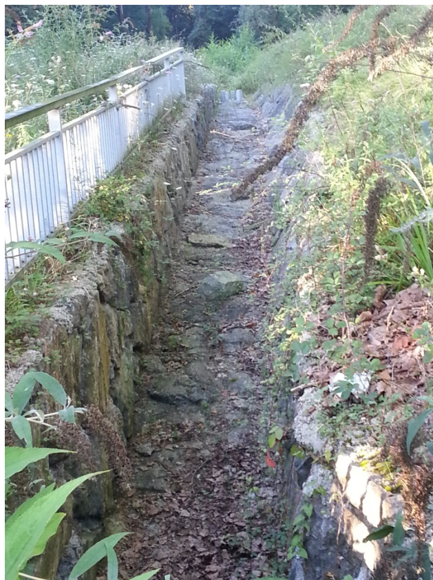
Foto 1. Canal de recogida de aguas con muros de escollera en el extremo noreste del ámbito.
